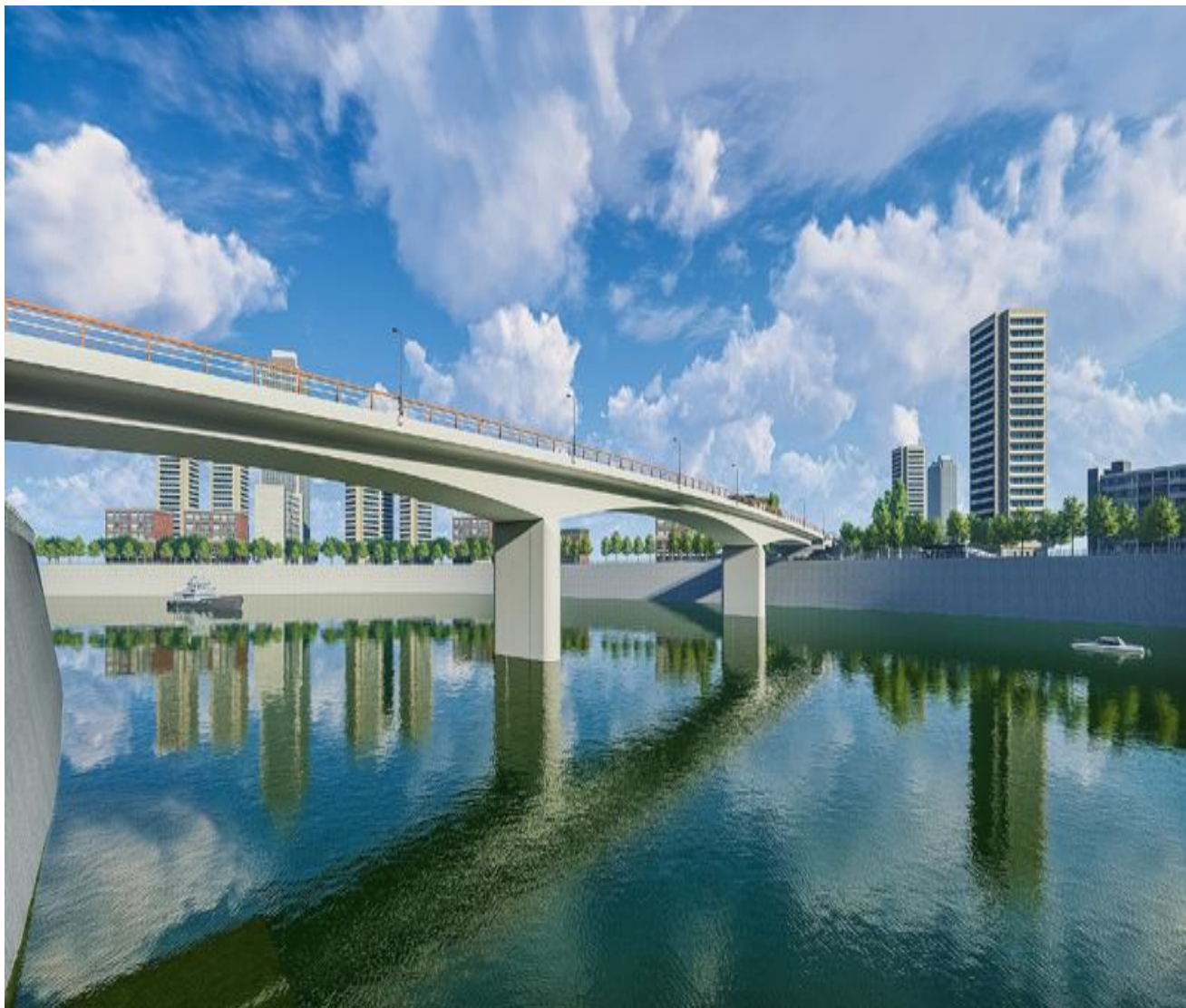
Cầu Ngòi Đường
